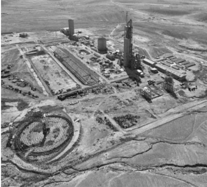
en service de la première ligne de production. La production de clinker s'élèvera à 4500 tonnes/jour, alors que la 2e ligne de production sera mise en exploitation ultérieurement. L'usine, qui s'étend sur 100 hectares, comprend également sept (7) carrières de pierre calcaire et une (1) carrière d'argile. Cette cimenterie implantée dans la région d'Oued Sdar, commune d'Ain El Ibel, est considérée
